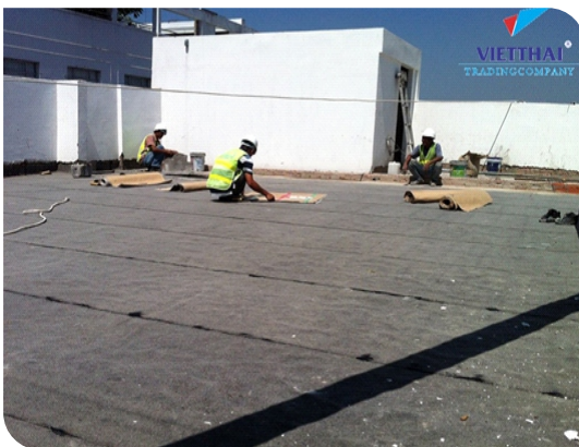
Thi công màng tự dính
