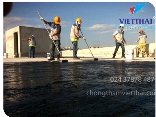
Thi công lăn lớp lót
