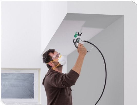
Thi công bằng máy phun
