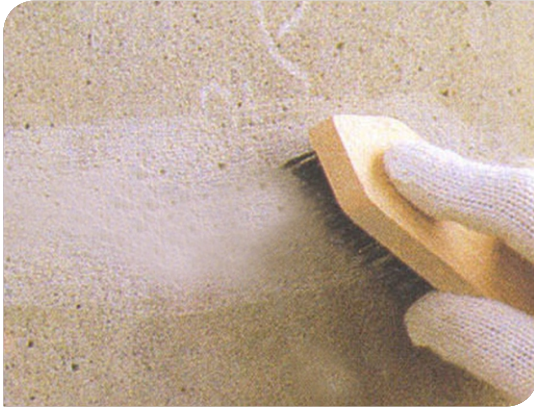
Vệ sinh chuẩn bị bề mặt
