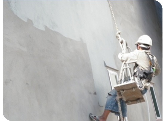
Thi công bằng con lăn
