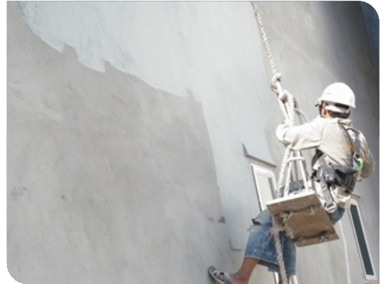
Thi công bằng con lăn
