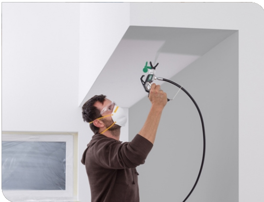
Thi công bằng máy phun
