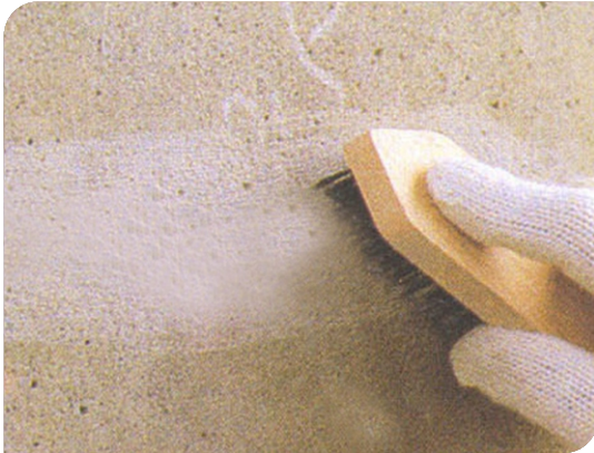
Vệ sinh chuẩn bị bề mặt
