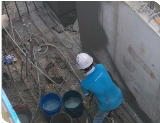
Thi công phun vách ngoài tầng hầm
