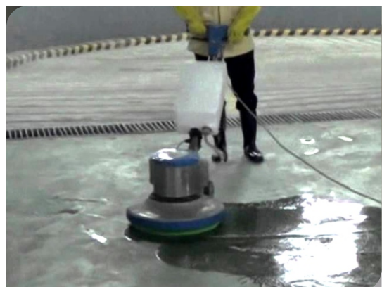
Dùng máy chà vệ sinh bề mặt
