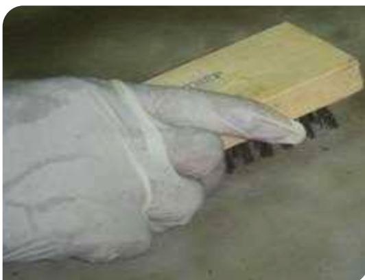
Vệ sinh chuẩn bị bề mặt
