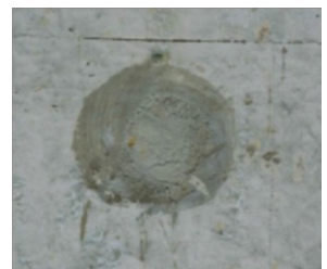
Trám lỗ ty bằng vữa sửa chữa Lanko 731
