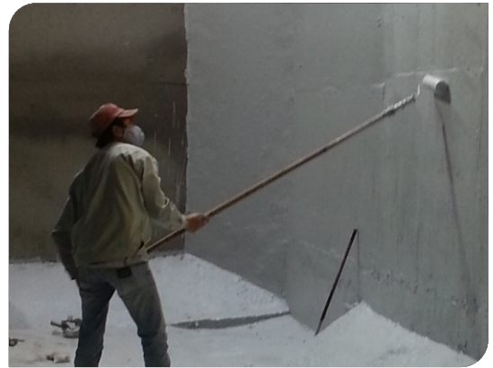
Thi công vách tầng hầm bằng lăn lu
