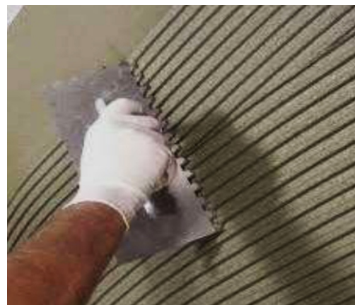
- Thi công với bay răng cưa hình vuông cho gạch lớn.
