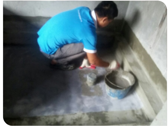
Thi công lớp thứ nhất
