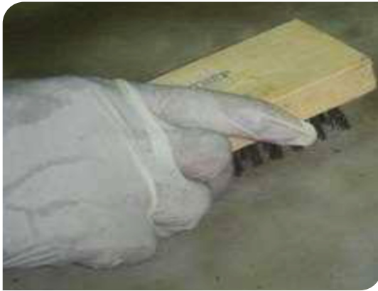
Vệ sinh chuẩn bị bề mặt
