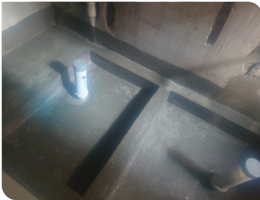
Thi công lớp thứ hai
