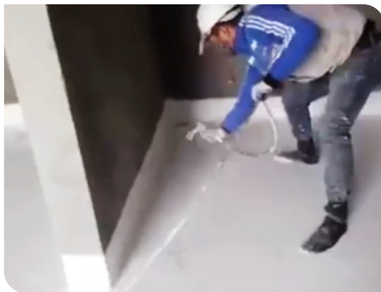
Thi công bằng máy phun
