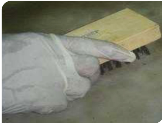
Vệ sinh chuẩn bị bề mặt
