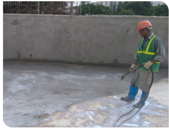
Thi công bằng máy phun
