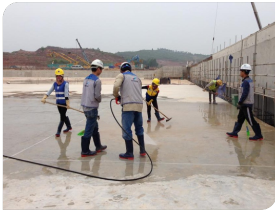
Vệ sinh chuẩn bị bề mặt
