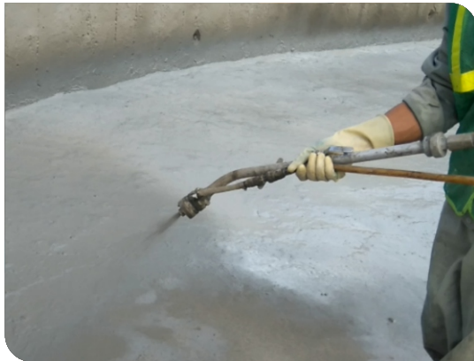
Thi công phun chống thấm
