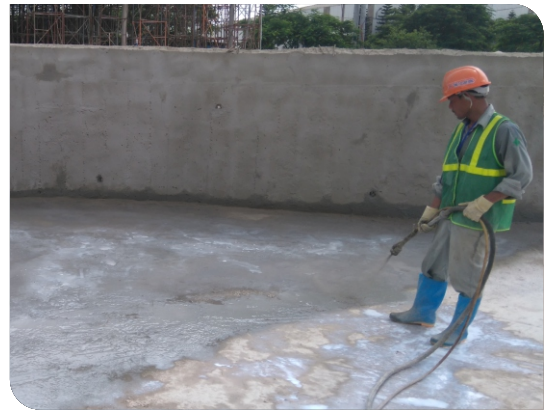
Thi công bằng máy phun
