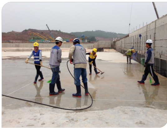
Vệ sinh chuẩn bị bề mặt
