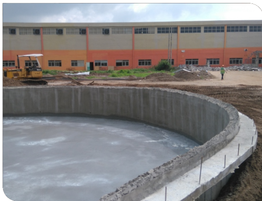
Bề mặt hoàn thiện
