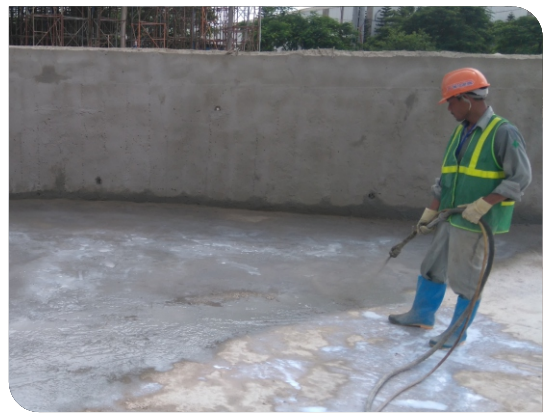
Thi công bằng máy phun
