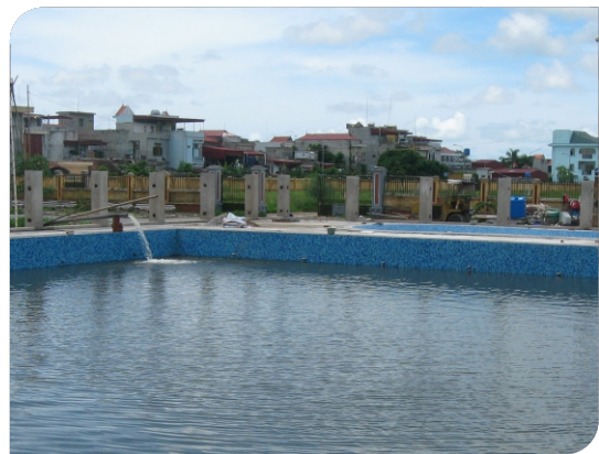
Bơm nước nghiệm thu công trình
