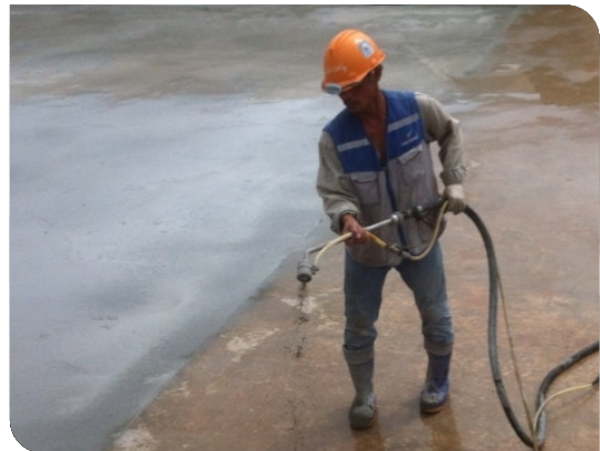
Thi công lớp thứ nhất
