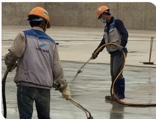
Thi công lớp thứ hai
