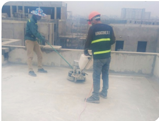
Vệ sinh chuẩn bị bề mặt
