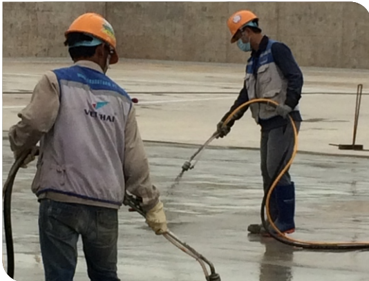
Thi công lớp thứ hai
