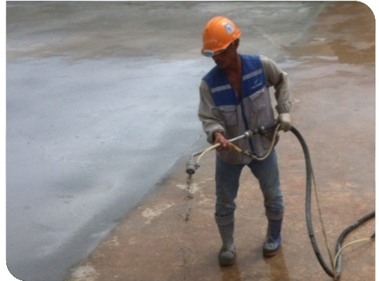
Thi công lớp thứ nhất
