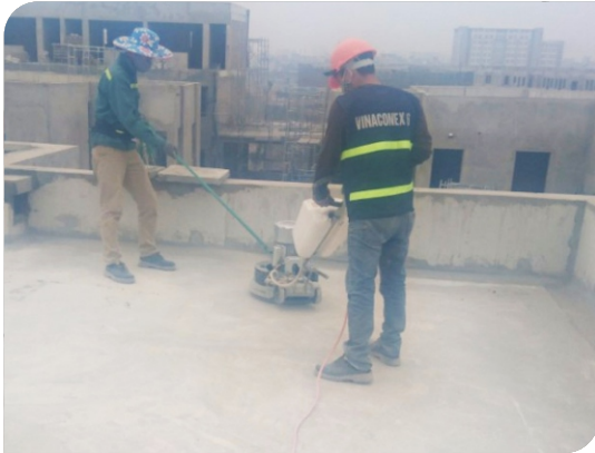
Vệ sinh chuẩn bị bề mặt
