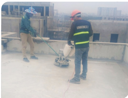
Vệ sinh chuẩn bị bề mặt
