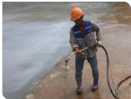
Thi công lớp thứ nhất
