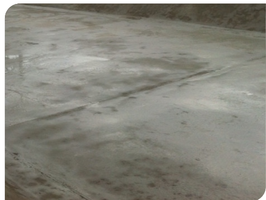
Bề mặt hoàn thiện
