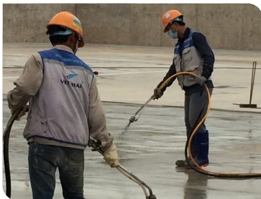
Thi công lớp thứ hai
